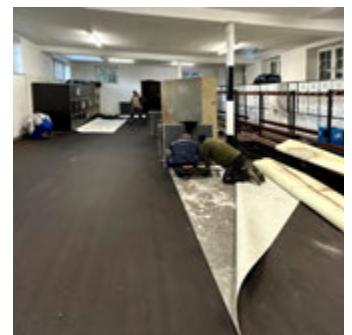
renouvellement du vinyle vestiaires
